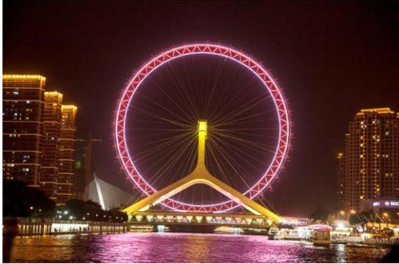
全称「天津永乐桥摩天轮」，亦是目前世界唯一一座跨河建造的桥上摩天轮，兼具观光和交通作用。摩天轮直径为 110 米，相等于 35 层楼高，可同时供 384 个人观光。
